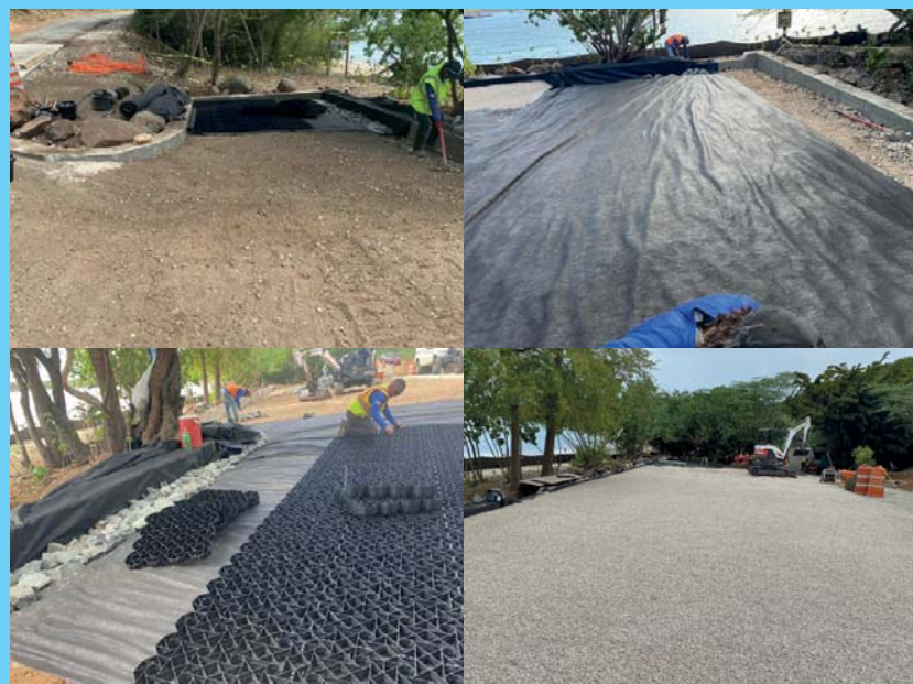
Figure 46 : Le processus de développement du parking perméable de la plage de Tamarindo (Source : PDC)
