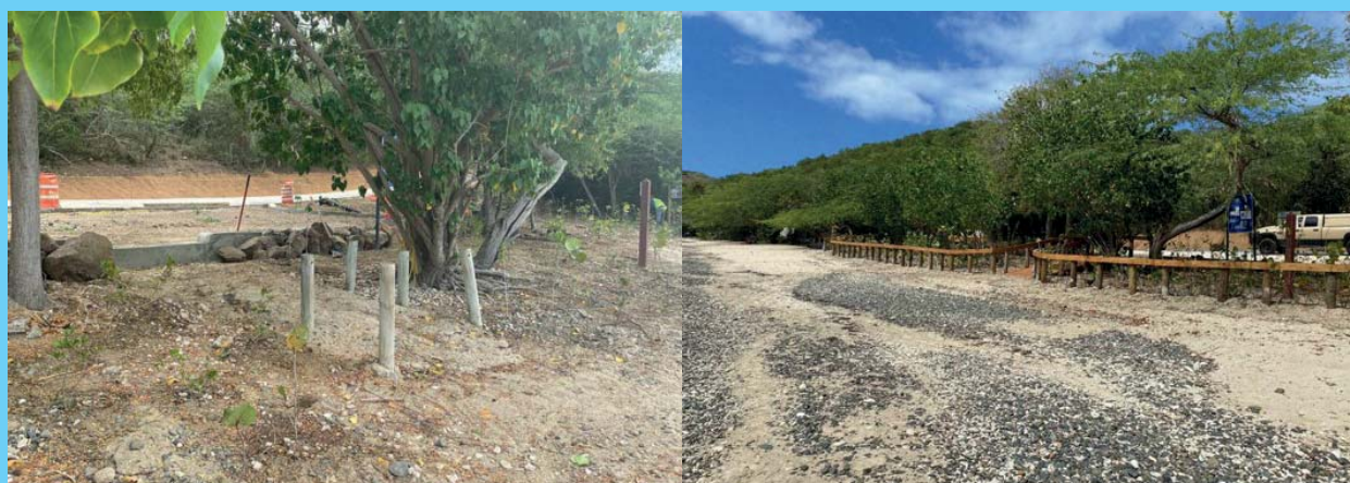
Figure 47 : Les poteaux en bois précédemment installés et endommagés (à gauche) ont été retirés et remplacés par de nouveaux poteaux en bois et des trottoirs en bois (à droite). (Source : PDC)
