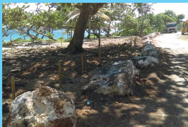
Figure 28 : Pose de blocs rocheux pour empêcher la circulation des voitures sur la plage (Source : Adam Gibaud (ONF); 22/10/2020)
